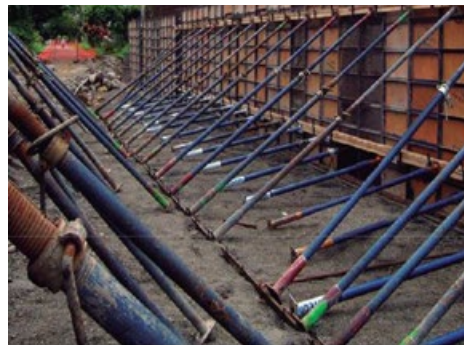
Apuntalamiento en encofrado de muros.
