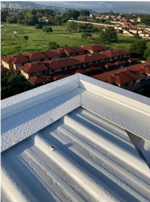
**Láminas de UPVC en perfiles T1130 y T940** es una cubierta termo acústica fabricada en UPVC (policloruro de Vinilo no plastificado) y PVC espumado en su interior.
