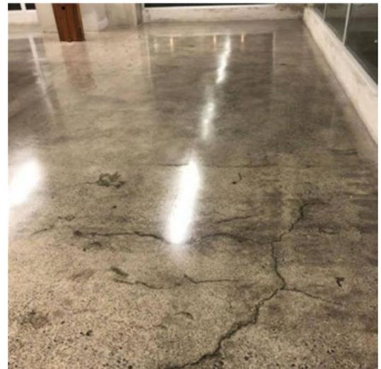
Sellador a base de polímeros de silicato que penetra las superficies de concreto incrementando la resistencia a la abrasión y reduciendo la absorción superficial de líquidos.
