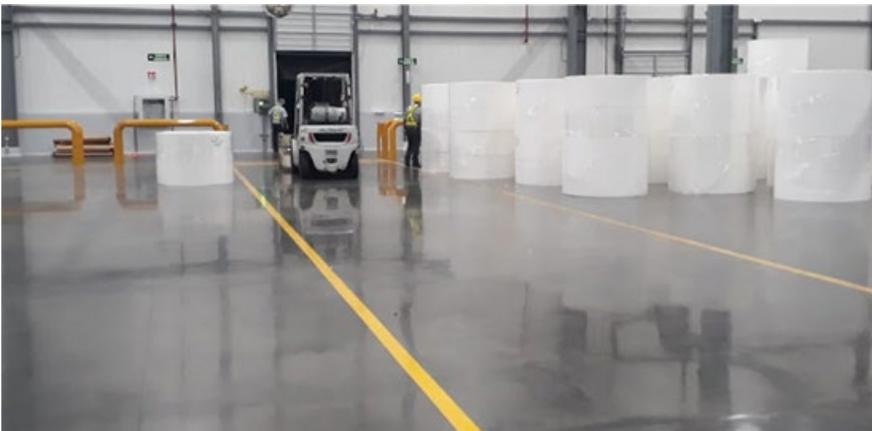
Diamond Plate es un endurecedor de pisos metálico de regado en seco con un agregado metálico graduado no oxidable (para lograr una mayor resistencia a la abrasión en áreas sujetas a humedades frecuentes o expuestas al agua) en un aglomerante cementicio de alta resistencia.
